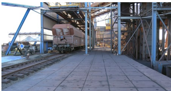
Úprava povrchov – južná strana. Surface reconstruction – southern side.
