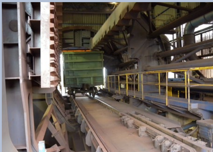
Zatlačanie loženého vozná ŠR do výklopníka. Shunting a loaded broad gauge wagon into the tipper.
