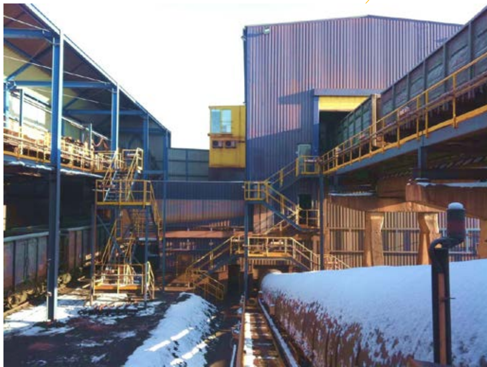
Prekládkový komplex Západ. Bulk Transshipment Centre West.
