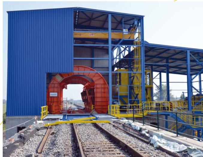
Z nájazdovej rampy vidieť ešte vo vnútri stavby oranžový kruh výklopníka, no čoskoro ostane schovaný až opláštením konštrukcie tak ako ostatné technologické celky. Seen from the drive-up platform can still be the orange circle of the dipper inside the construction, but it will soon be sheathed as the other technological units.
