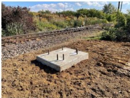
Základ č. 5 po oddebnení a zasypaní terénu do pôvodného stavu.
